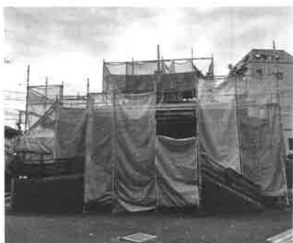
改修中の納骨堂
